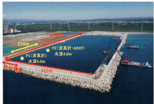
図-2 灰捨場護岸全景
