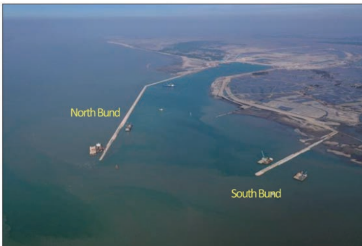
図-2 港湾工事の状況 (2020年1月)
