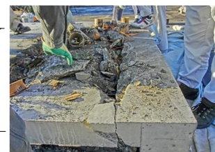
写真-23 破碎状態
