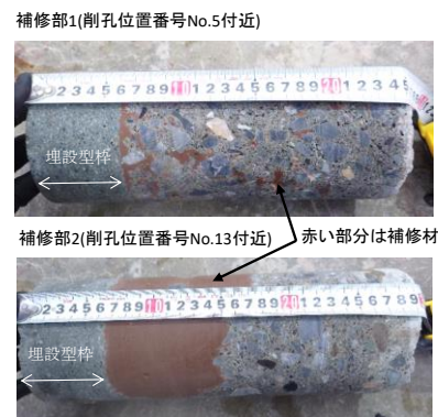
図-10 コア抜きした供試体
