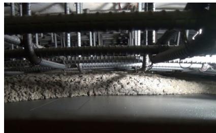
写真-5 覆工天端部の流動状況
