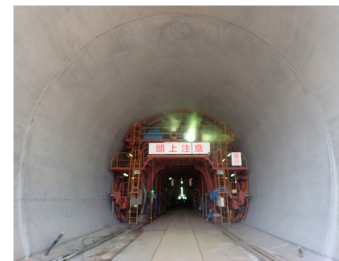
写真-6 覆工コンクリートの仕上がリ
