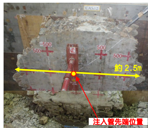
写真-3 捨石への注入実験出来形
