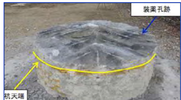
写真-5 水平破断面（天端）
