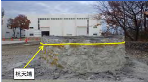
写真-6 水平破断面(側面から)
