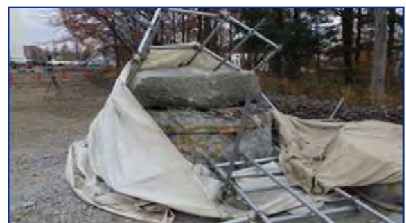
写真-4 破砕直後（ずれ防止倒壊）
