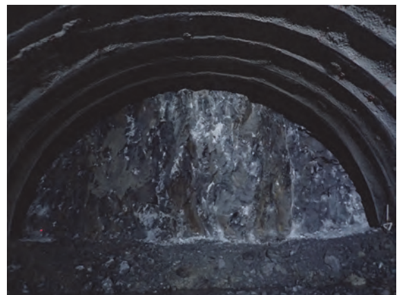
写真4 実証区間で確認した切羽状況 (665基)
