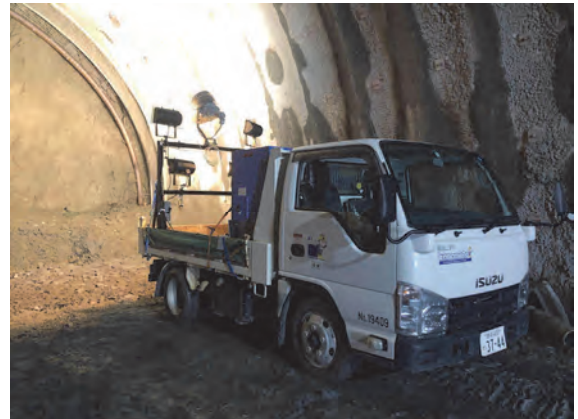
写真3 撮影時に使用した照明設備
