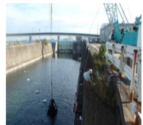
写真-2 改質土投入状況
