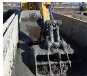
写真-1 改質土作製状況
