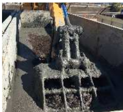
(a) 改質土混合状況 (b) 改質土投入状況(直接投入) 写真-1 改質土混合・投入状況
