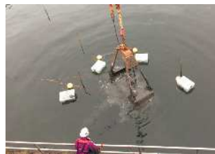
(a) 改質土混合状況 (b) 改質土投入状況(直接投入) 写真-1 改質土混合・投入状況
