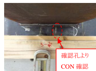
写真-2 梁下充填確認孔
