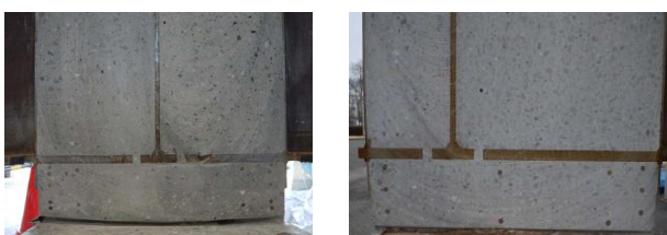
写真一6 切断面(試験体 2) 写真一7 切断面(試験体 3)
