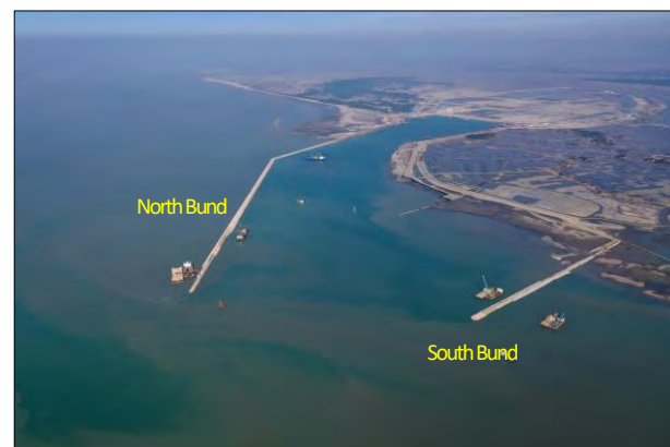
図-2 港湾工事の状況（2020年1月）
