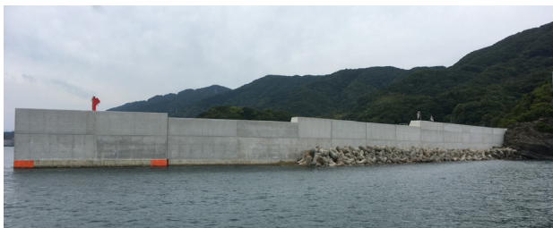
図-3 対象構造物の全体写真
