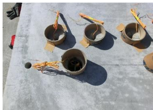
写真-18 破砕ライン形成用(手前)と鉄筋露出用(向こう側)の装薬・型枠
