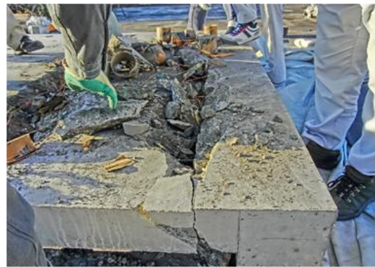
写真-23 破砕状態 (RC 部側)
