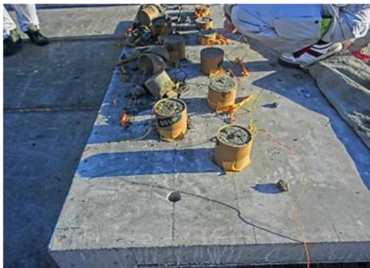
写真-22 破砕ライン形成 (デッキ部・端部)
