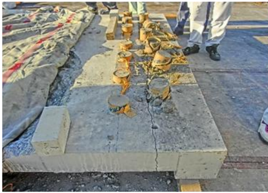
写真-21 破砕ライン形成 (RC 部側)
