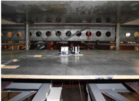
写真-2 駆動部架台・傾斜計取付け状況
