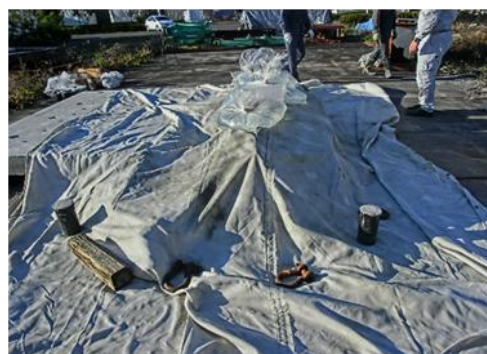
写真-20 防爆・防音養生
