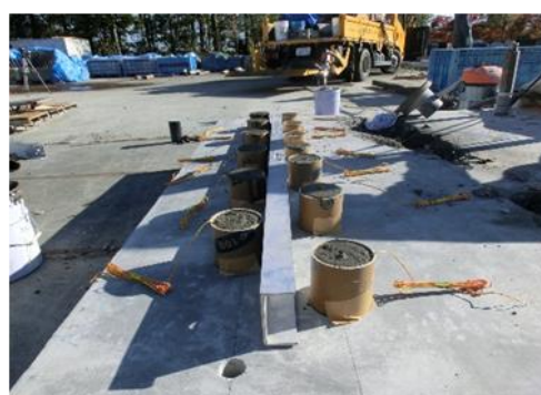
写真-19 モルタル充填完了
