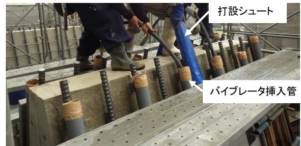
図-5 増し厚部のコンクリート打設状況
