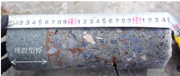
補修部2(削孔位置番号No.13付近) 赤い部分は補修材
