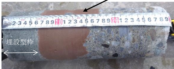
図-10 コア抜きした供試体
