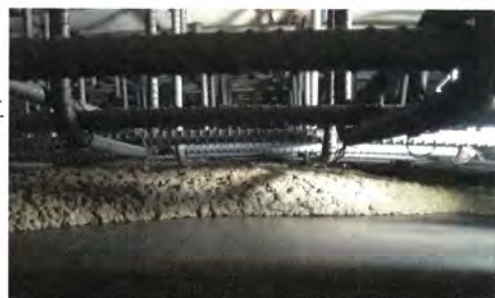
写真-5 覆工天端部の流動状況
