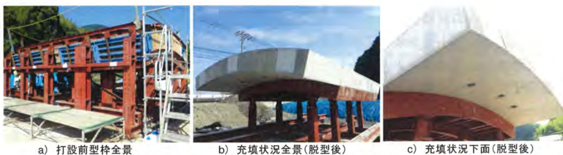
写真－3 試験施工における型枠と充填状況
