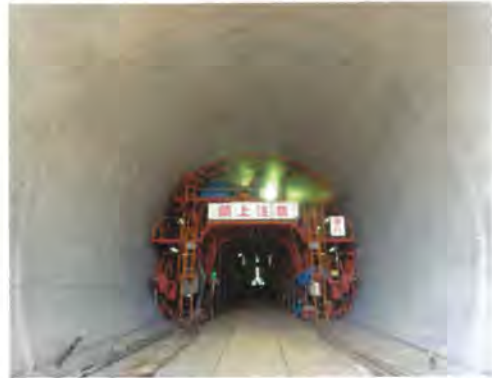
写真－6 覆工コンクリートの仕上がり
