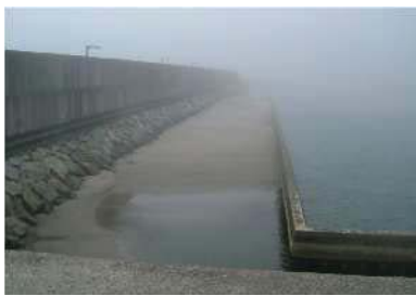
写真-1 震災前の傾斜堤と透過防止工間の堆積状況
