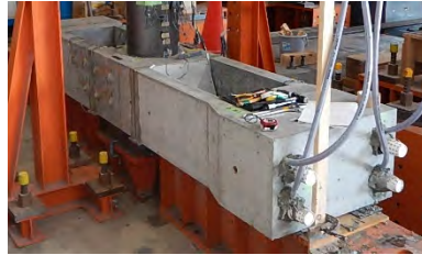
写真-5 PC グラウト養生
