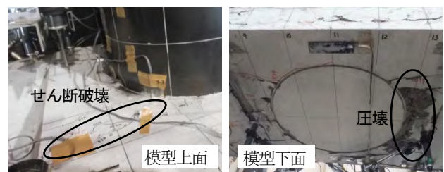
写真-8 PC 圧着構造の損傷形態(実験終了後)
