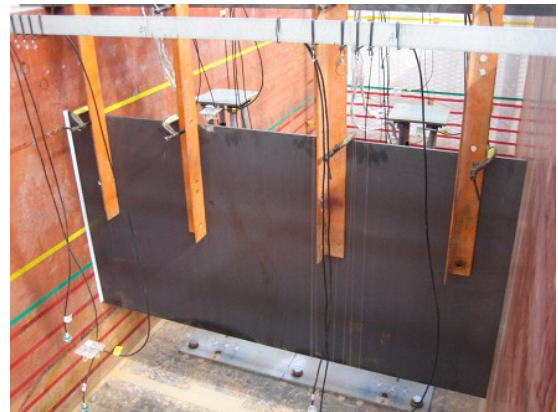
(b) 鋼板設置 (治具固定) 完了
