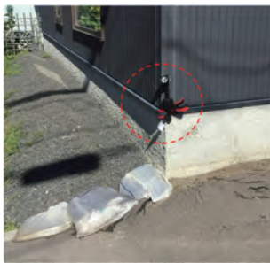
図 14 プリズムの設置状況
