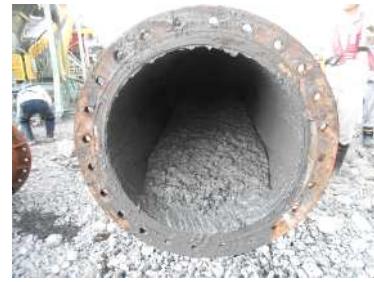
写真-7 圧送距離40mの配管内の状況
