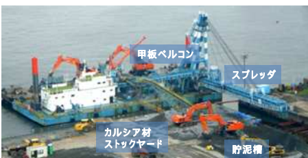
写真-4 リクレーマ船の状況
