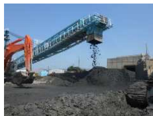
写真-5 スプレッドからの落下
