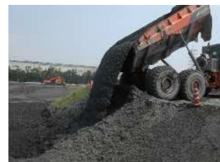
写真-6 打設地点
