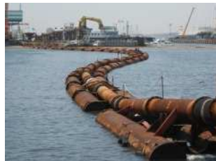
写真-2 圧送配管
