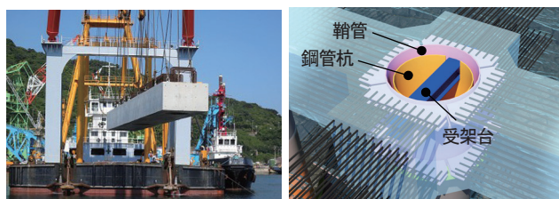
写真-1 栈橋上部工の架設 写真-2 鞘管方式の接合
