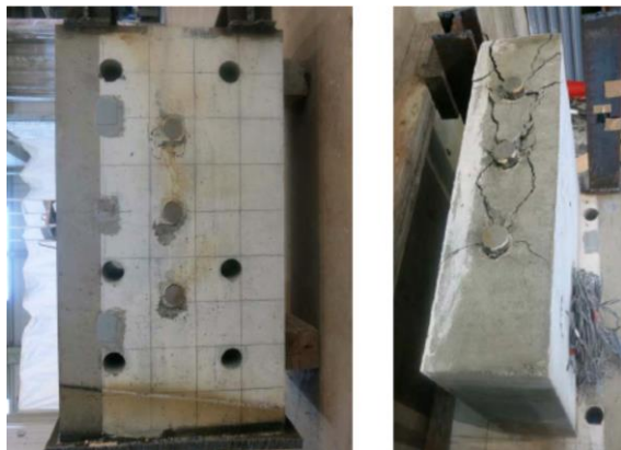
(a) 既存部 (b) 増設壁側
