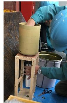
可塑性グラウトは陸上にて練り混ぜを行い、コーキングカートリッジに充填後、潜水士に渡して注入を行った（写真-4）。注入は、コーキングガンの先端をゴムシートの切り込みに挿入し、シートのかぶり状況やコーキングガンの圧力から注入が困難であると潜水士が判断するまで注入作業を行った。
