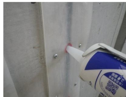
写真-2 シリコンゴム (t=2mm) と注入孔
