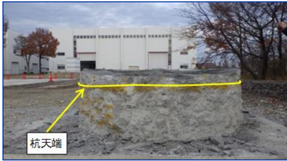
写真-6 水平破断面(側面から)
