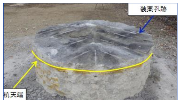
写真-5 水平破断面(天端)
