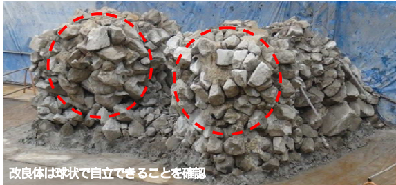
写真-9 改良体の出来形
