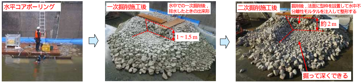
写真-8 増深工法の施工手順検証
