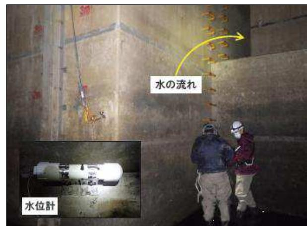
図-4 水位センサーの設置状況
