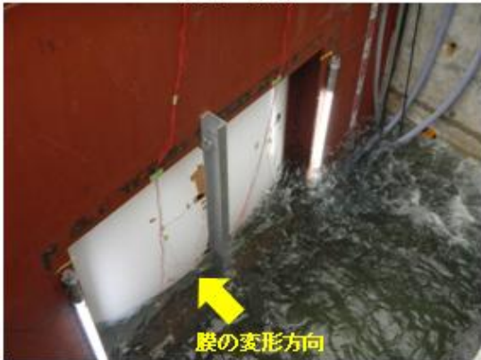
②注水完了時(背面)
