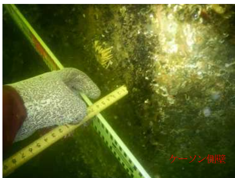
写真-3 ケーソン段差計測状況
