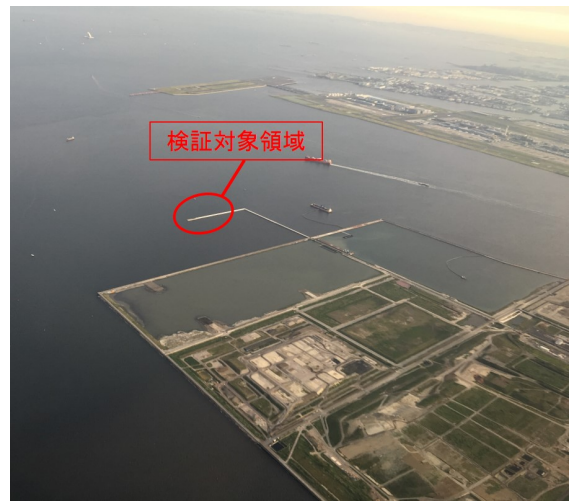
図-10 東京湾新海面処分場Dブロック南側護岸建設工事現場
