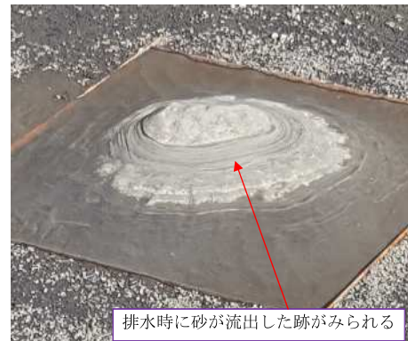
写真-6 砂面形成完了
