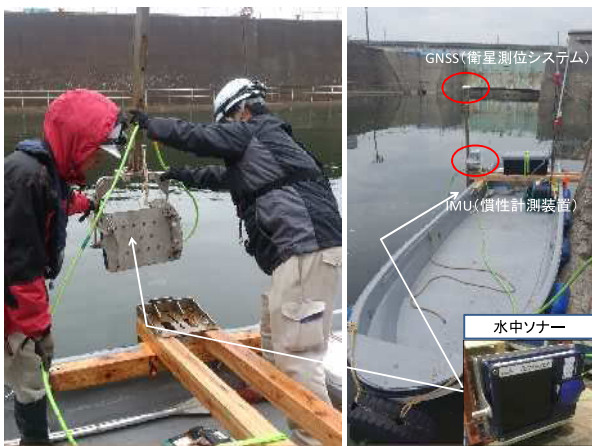
写真-1 水中ソナーシステム機装状況
