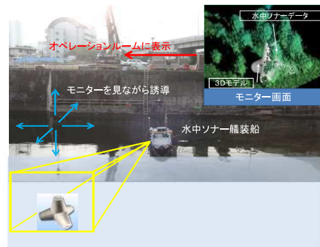
写真-3 消波ブロック据付サイクル
