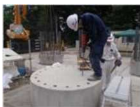
写真-11 豎孔削孔 (試験体 1'および 2')
