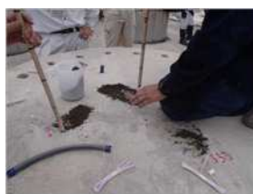
写真-13 込め物(砂)
