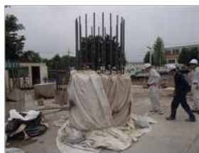
写真-15 防爆養生 (試験体 1'および 2')
