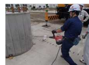
写真-4 横孔削孔
