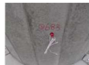
写真-6 装薬容器挿入
