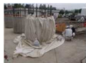
写真-8 防爆養生
