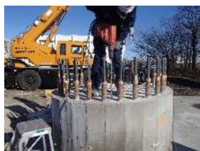
写真-12 豎孔削孔 (試験体 A)
