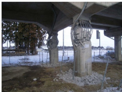
写真-2 第一中曽根高架橋の損傷状況(起点側)
