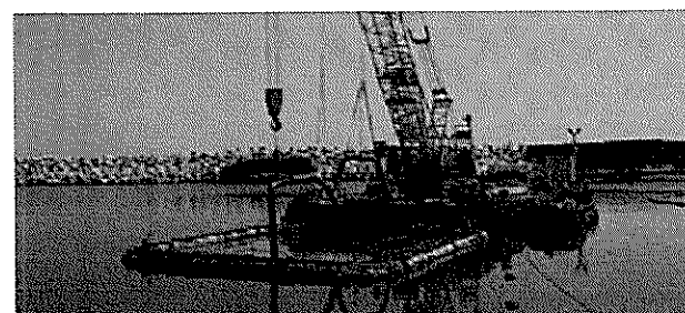
写真5 処理土による覆土の作業全景
