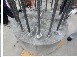
写真-10 破断面の状態(試験体 1)
