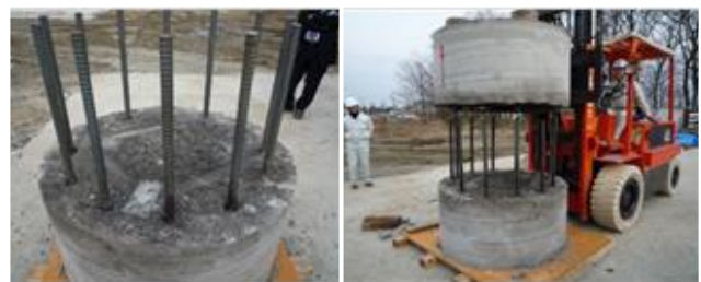
写真-1 破断面の状態
