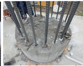
写真-20 破断面の状態 (試験体 3)
