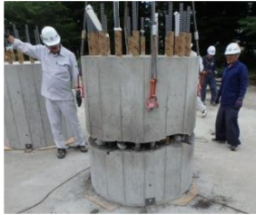
写真-9 杭余盛り部の揚重(試験体 1)
