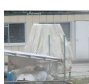
写真-7 防爆養生 (試験体1)
