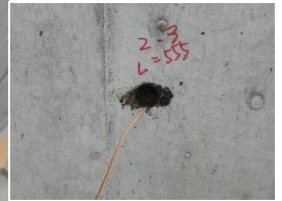
写真-6 装薬・充填 完了(試験体1)
