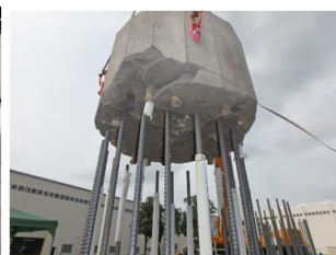
写真-25 杭余盛り部の 揚重 (試験体 4)
