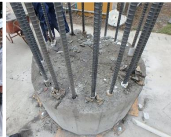
写真-15 破断面の状態(試験体 2)
