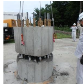
写真-14 杭余盛り部の揚重(試験体 2)
