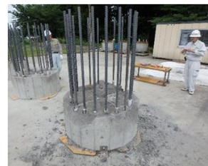
写真-24 破断面の状態 (試験体 4)
