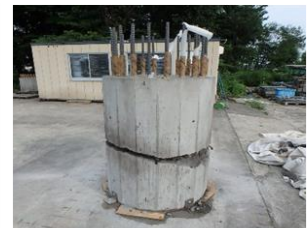
写真-23 破砕直後の 状態 (試験体 4)
