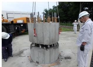
写真-19 杭余盛り部の 揚重 (試験体 3)
