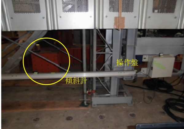
写真-9 傾斜計・操作盤設置
