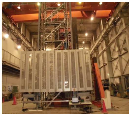
写真-1 仮囲い組上がり状態
