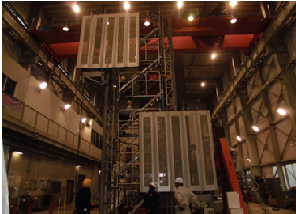
写真-4 北側(左側)駆動機上昇
