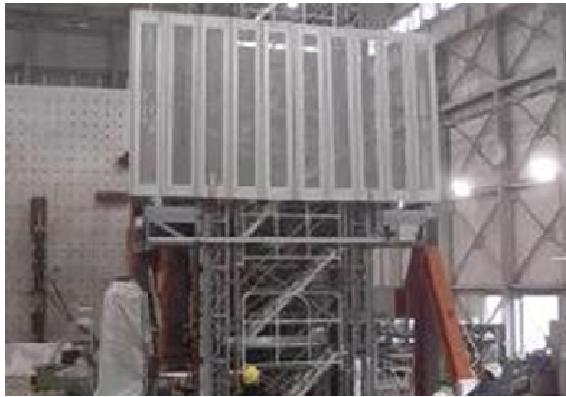
写真-7 駆動機2台上昇中
