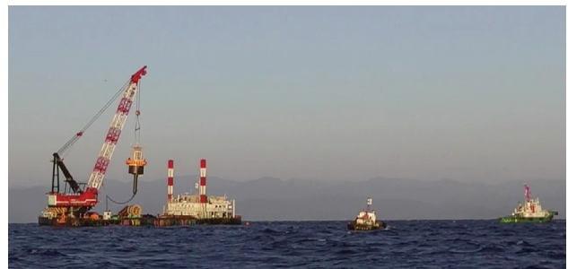
写真-1 GPS波浪計設置状況
