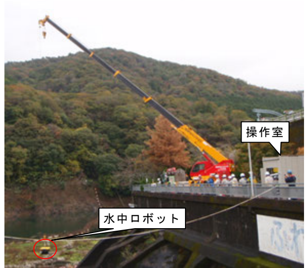
写真-9 天ヶ瀬ダム現場実証状況(投入)
