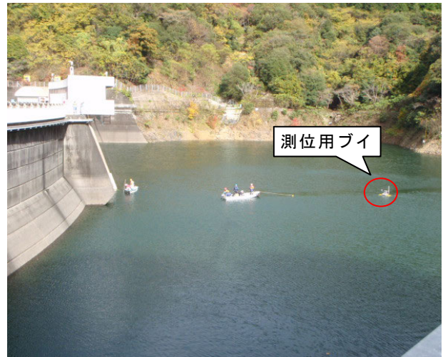
写真-10 天ヶ瀬ダム現場実証状況(調査)
