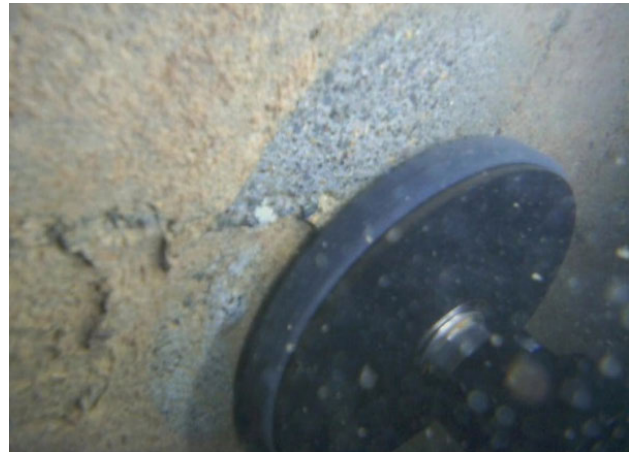
写真-5 壁面清掃状況
