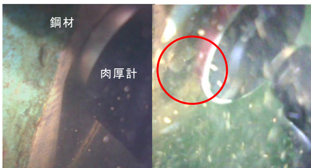
写真-16 予備ゲート精査
