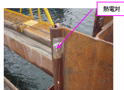
写真-2 継手部の温度計測状況
