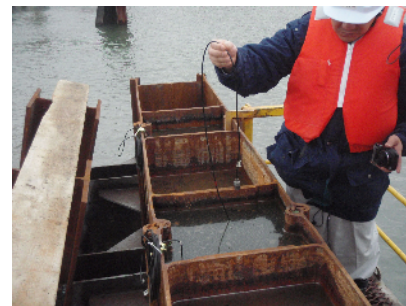
写真-3 水張試験の状況
