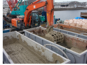
(a) ミキシングバケットによる混練
