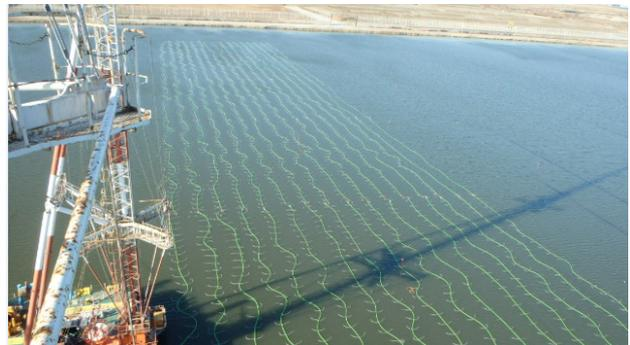
写真-4 水上に浮かんだ集水管(負圧作用前)
