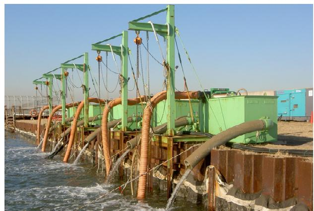
写真-5 真空ポンプ運転中の排水状況
