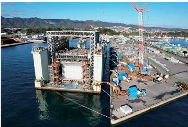
写真-1 海上での施工状況
