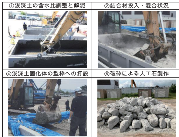
写真-1 施工状況と浚渫土固化体人工石
