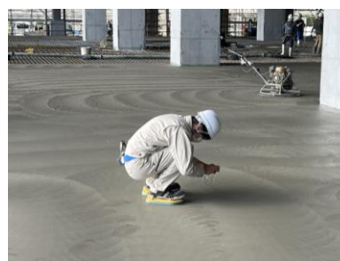
写真-4 デュロメータ値測定状況(現場)
