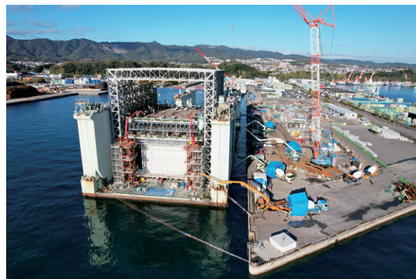
写真-1 海上での施工状況
