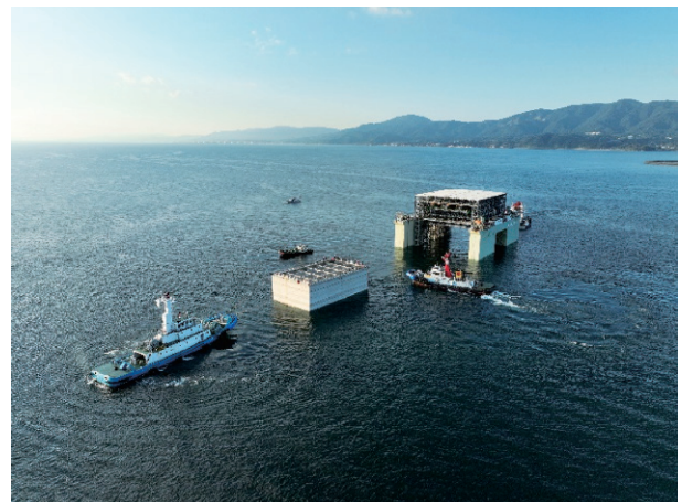
写真-8 ケーソン曳きだし
