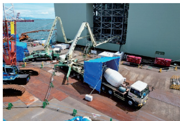
写真-5 ポンプ車配置状況
