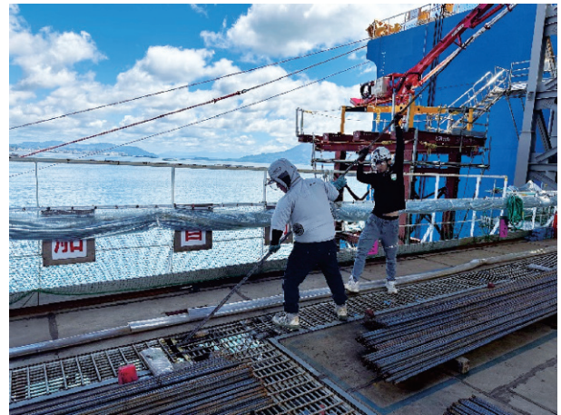
写真-6 上層から中層への鉄筋供給
