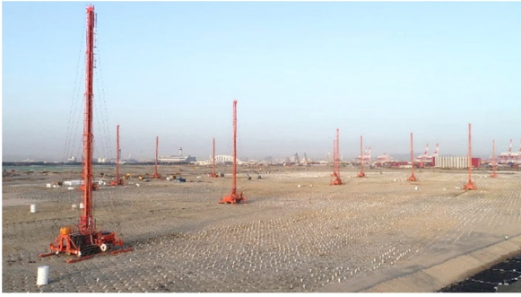
写真-1 PBD 打設状況
