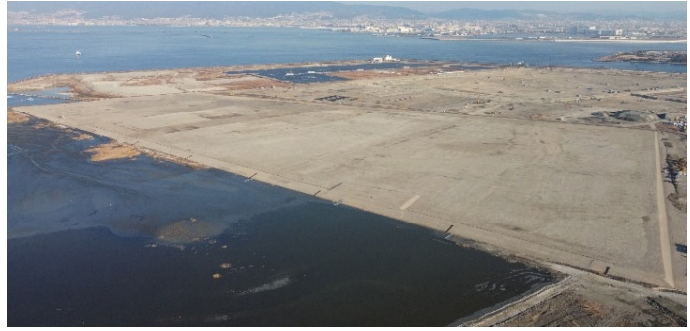
写真-2 盛土造成完了
