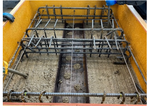
写真-1 孔あき試験体へのコンクリート打込み状況
