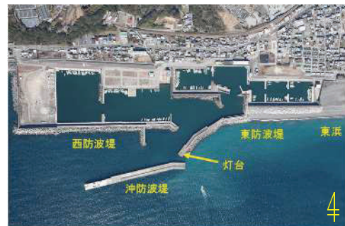
図-1 高知県安芸漁港全景 注1)
