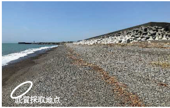
図4 安芸漁港東浜側からみた東防波堤前面側
