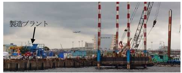
写真-5 可塑状グラウト注入状況 (全景)
