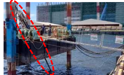
写真-4 夾雑物除去の作業状況（削孔）
