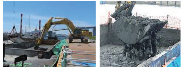
写真-2 カルシアバケットの使用状況
