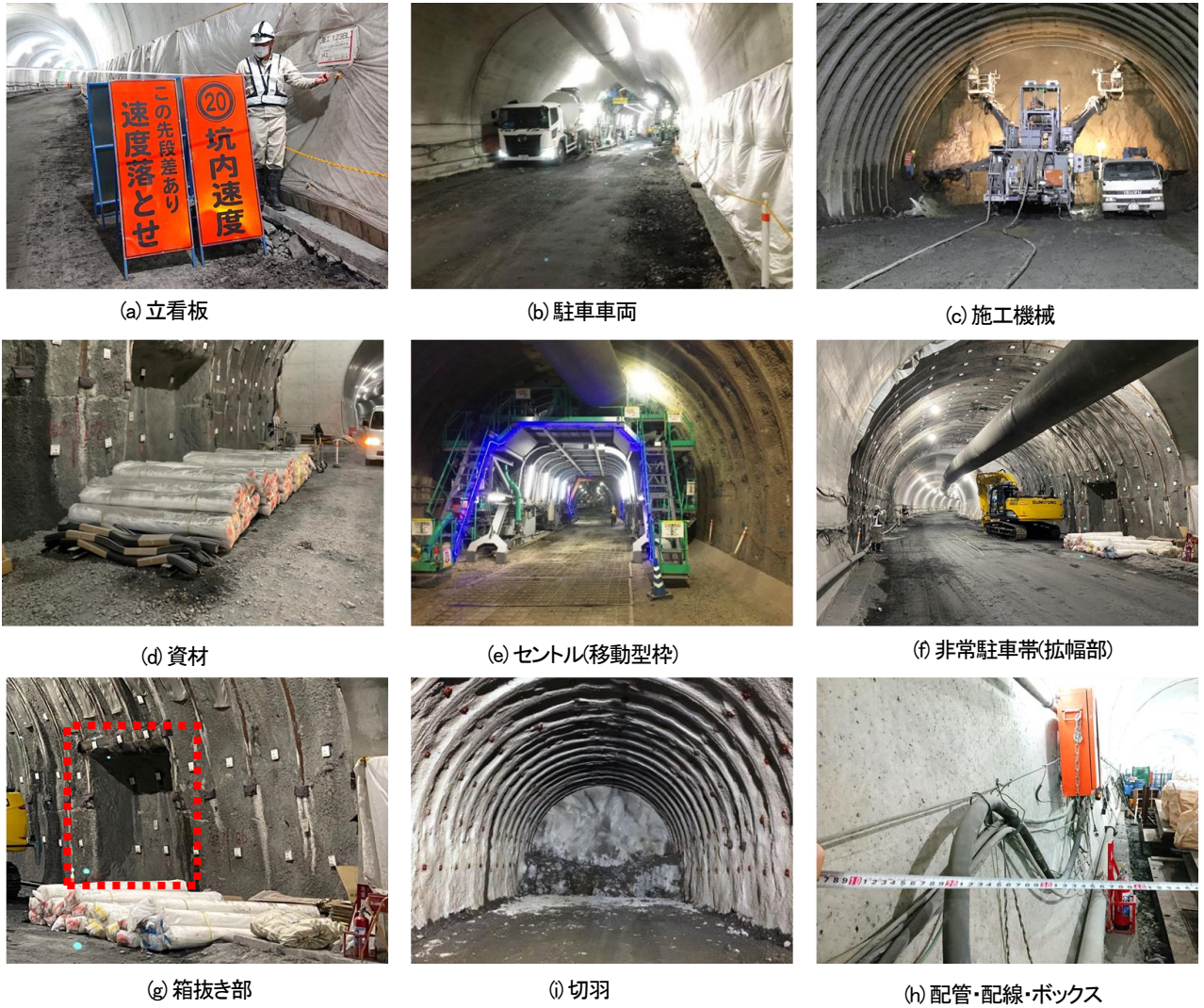
写真-2 施工期間中の山岳トンネル内の状況
