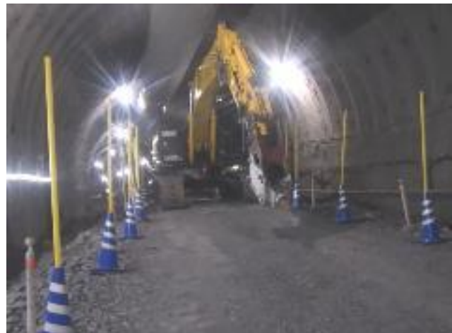
写真-5 狭所の走行試験(通路幅約4.0m)
