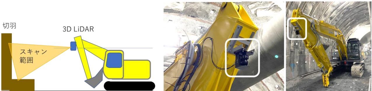
図-13 3D LiDAR設置状況(アームの付根に設置)
